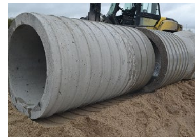
Op gezaagde spie-einden EasyLock-ring aanbrengen
